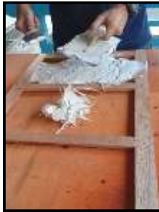
Langkah 4: Menempatkan bancuhan ke dalam kotak bentuk, dipadatkan dan diratakan
