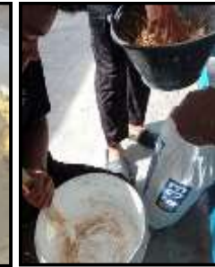
Langkah 3: Membancuh gypsum, air dan serat batang pisang sehingga sehati
