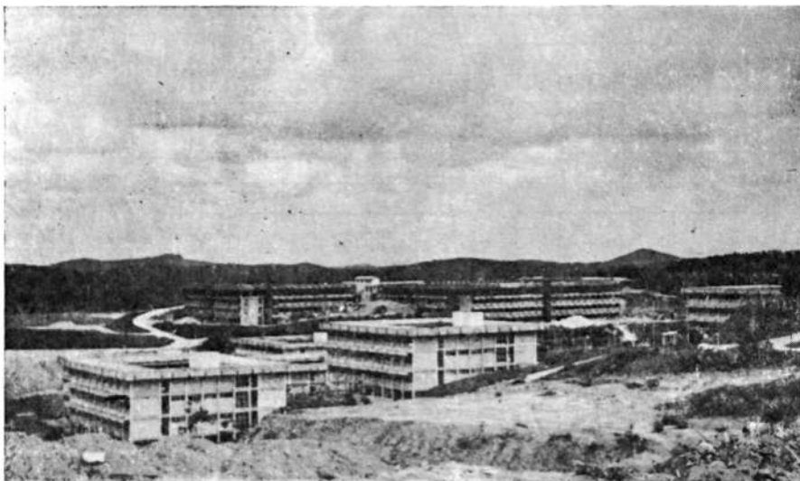
Bangunan dalam progres.
