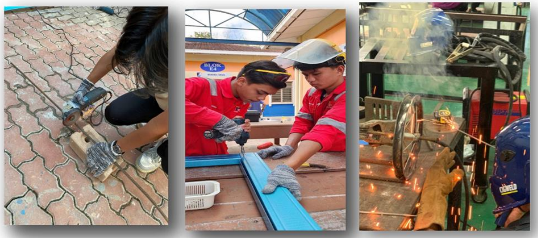
Rajah 3.3 : Kerja pemotongan besi tetulang, penggunaan C-Channel serta kerja kimpalan dalam projek Saa Agg FILTER
