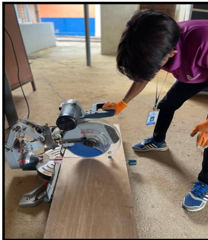
Rajah 3: Memotong plywood untuk di jadi kan tapak.
