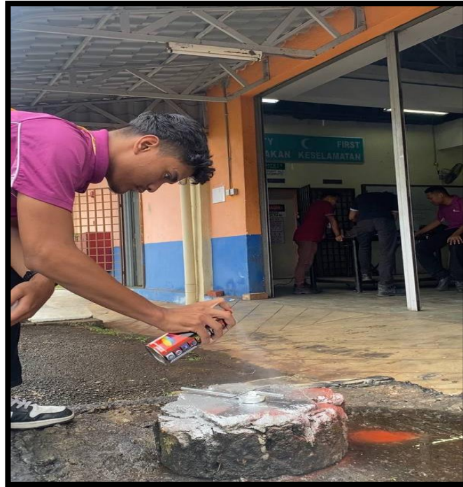
Rajah 7: Langkah 5 Spraykan bahan supaya tidak karat
