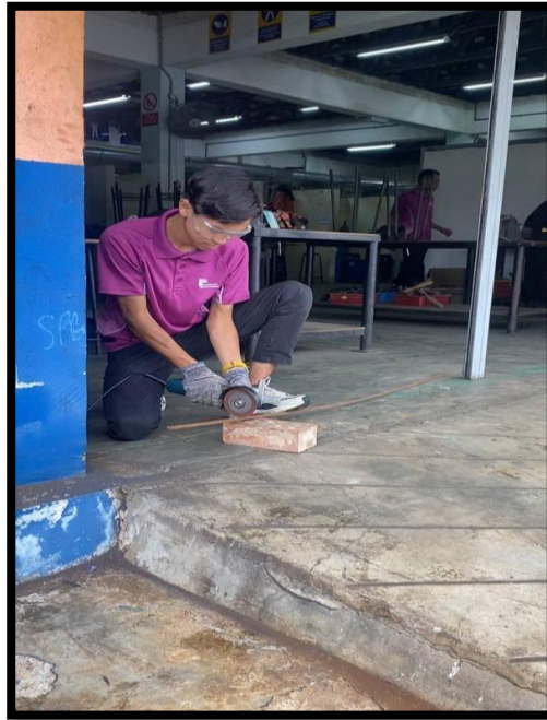
Rajah 3: Langkah 1 memotong besi untuk membuat pemegang
