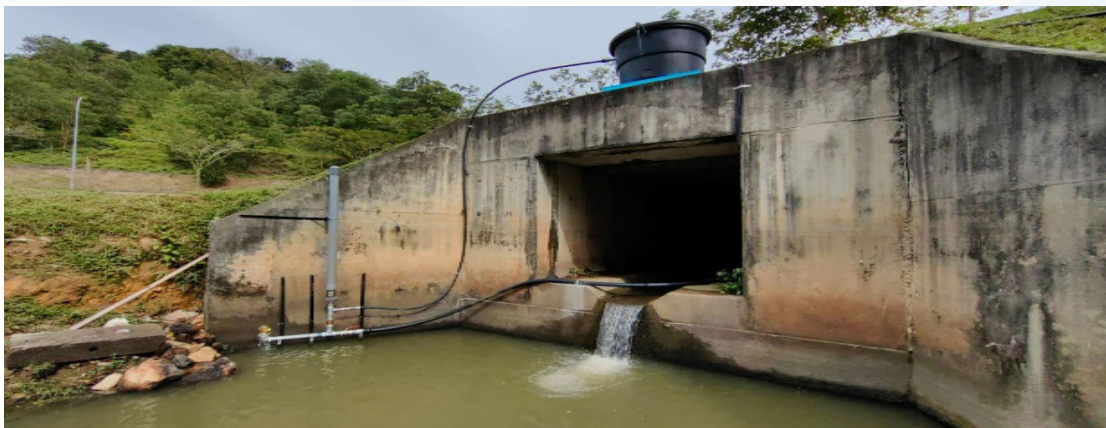
Pemasangan Hydraulic Ramp Pump
