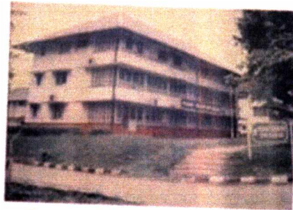
Bangunan Pejabat Residen dan Daerah (1988-1998) @ Bangunan Yayasan
