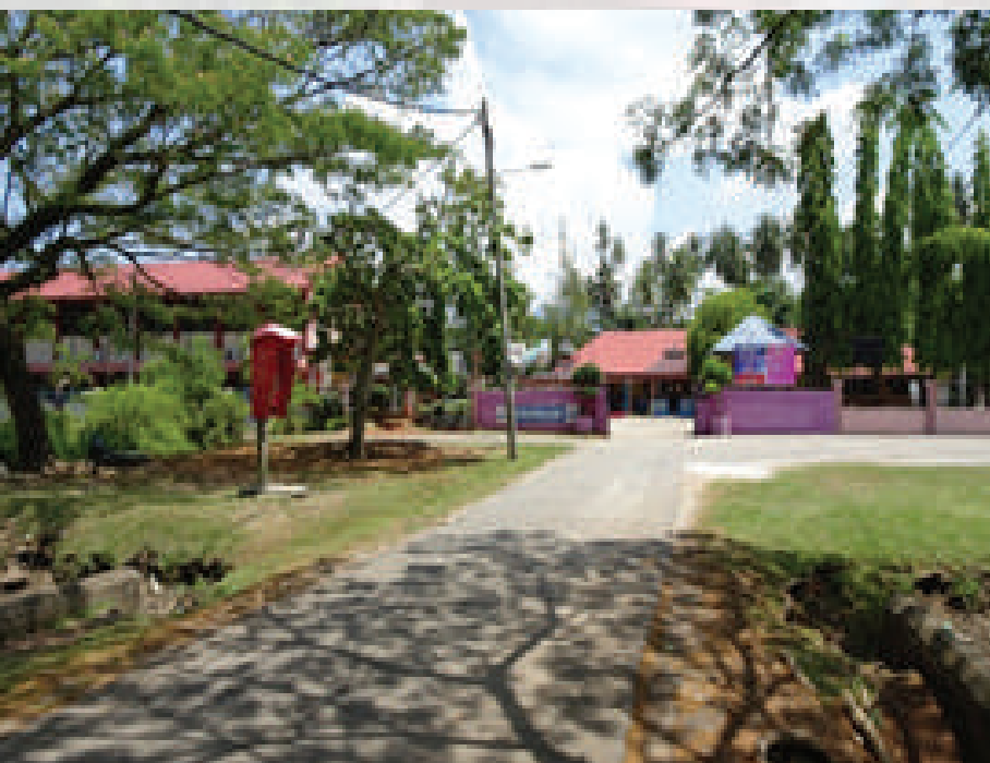
Gambar 2.26: Jalan menuju ke Sekolah Kebangsaan Tanjung Dawai
